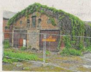
So sah die Schienenfahrzeughalle im Sommer 2009 aus.
