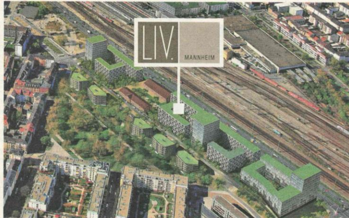
LIV. entsteht auf Baufeld 3, neben dem denkmalgeschützten Lokschiuppen-Ensemble und gegenüber dem Hanns-Glückstein-Park. BILD: D&S
