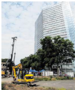
Am Victoria-Turm werden für den Neubau die Fundamente vorbereitet. BILD: ROS
