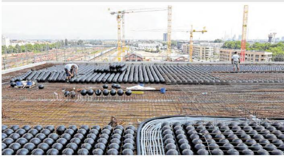
Blick vom Obergeschoss des MPB-Parkhaus-Rohbaus in Richtung Südosten: Das Glücksteinquartier wird jetzt Stück für Stück fertig. Die Kunststoffkugeln im Stahlbeton dienen der Material-Ersparnis. BILD: B. DITTMER
