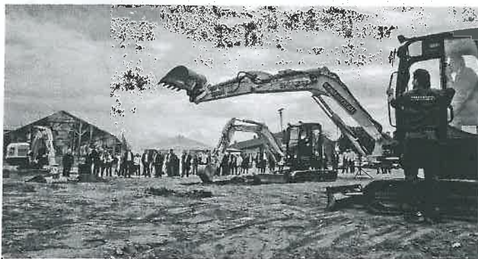
Mit einem Bagger- statt Spatenstich wurde bereits Anfang Juli der Startschuss für das „Quartier hoch 4“ gegeben. Bild: Raffler
