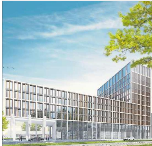
70 Prozent der Fläche sind schon vermietet: So soll der Gebäudekomplex, der Mitte 2019 fertig sein soll, dann aussehen. ENTWURF: GERCHGROUP/FREI
